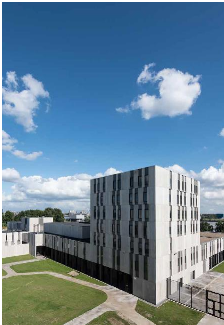
Un très grand nombre de blocs de travail sont aménagés dans la partie centrale.
